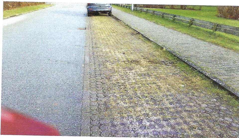
Figur 6. Parkeringsbås langs stamvejen. Mosbevoksning, græs op ad kantsten, manglende fugemateriale.
