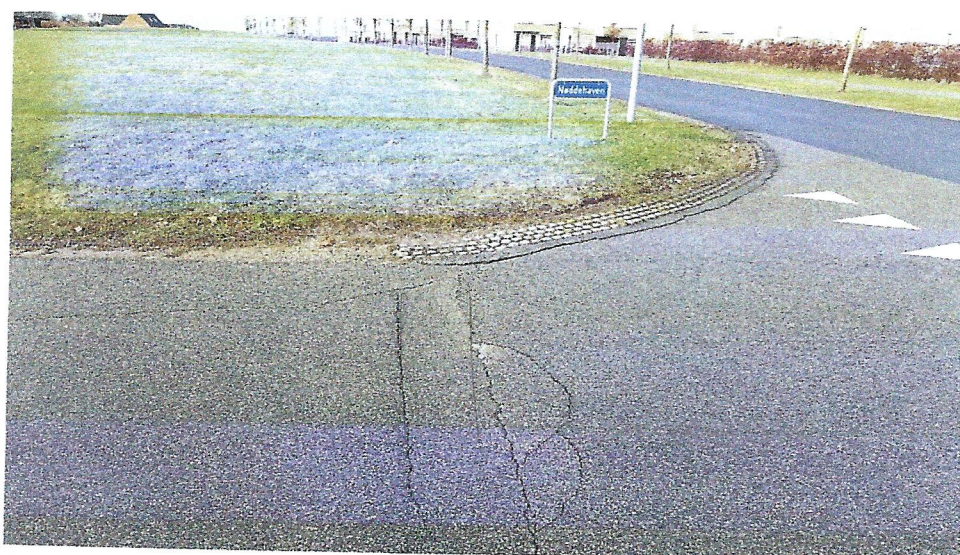
Figur 3. Nøddehaven – krydset ved Olaf Becks Allé med sunket ledningsgrav og revner langs vejhjørnet.
